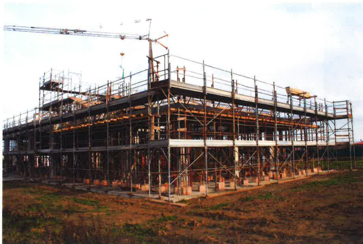
foto del centro in corso di costruzione
