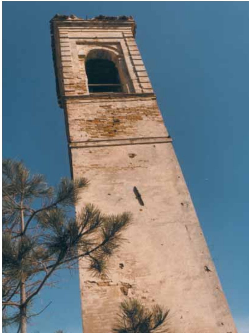
Piagge, Torre Civica, prima del restauro
