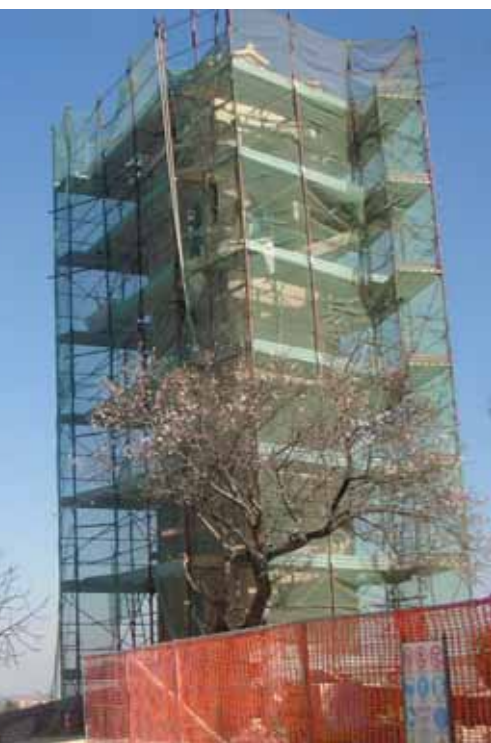
Piagge, Torre Civica, durante i lavori di restauro
