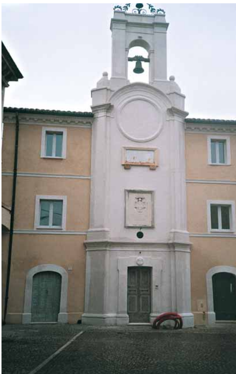
Monte Porzio, facciata dell'ex sede comunale e scala interna dopo il restauro
