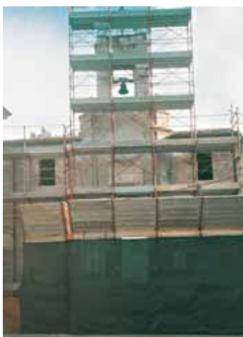
Monte Porzio, facciata dell'ex sede comunale durante il restauro
