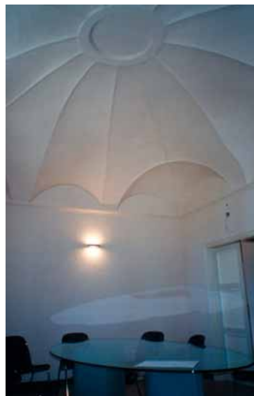
S. Martino di Saltara, volta (ad ombrello) di un ambiente restaurato della Villa del Balì
