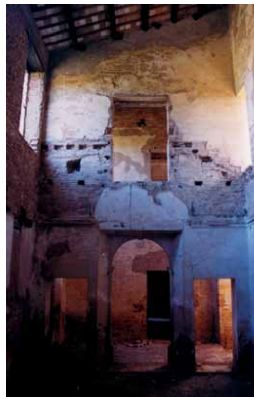
S. Martino di Saltara, scorcio dell'interno della Villa del Balì prima dell'intervento di restauro
