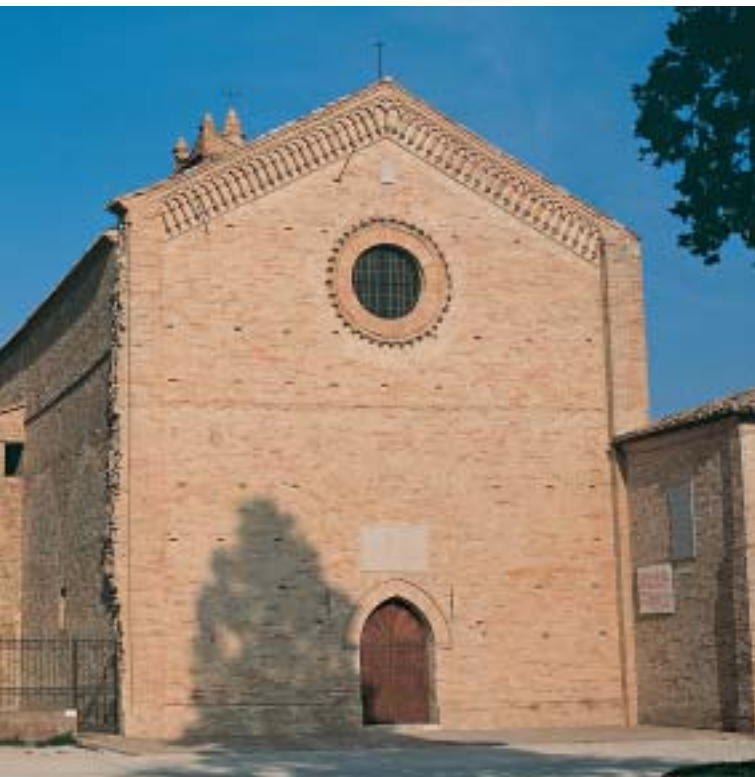
Facciata della chiesa
